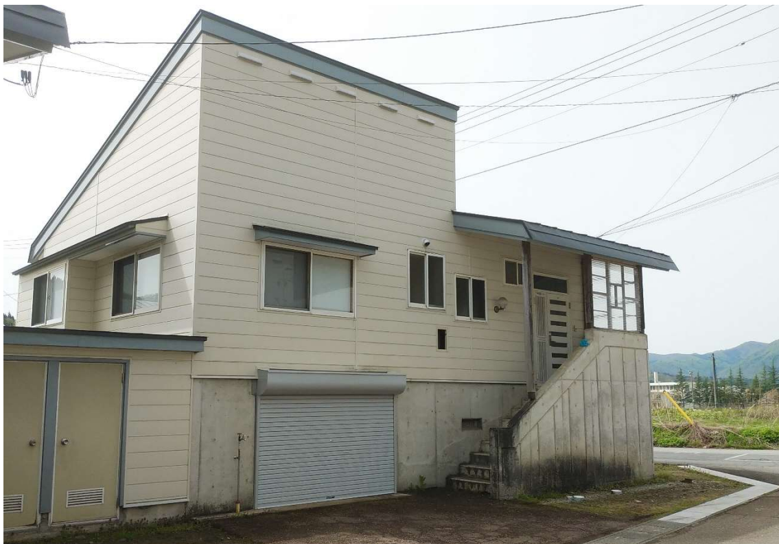
愛宕住宅D-1 (最上町大字向町862番地の7) 昭和63年(1988年)建築
