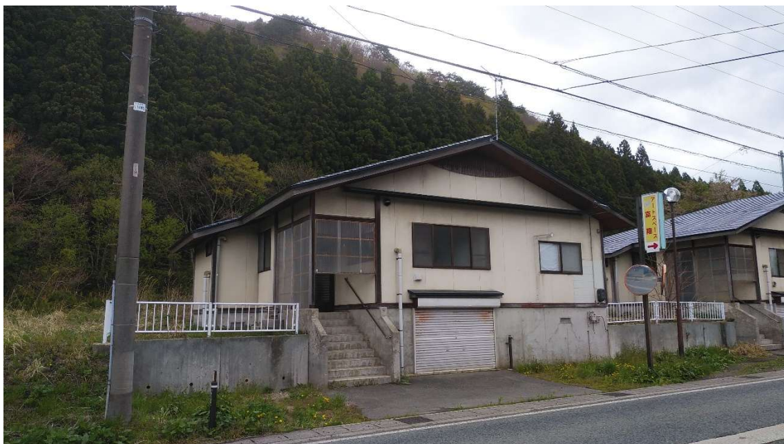
富沢住宅 2号 (最上町大字富沢 1 1 7 6 番地の 6) 平成 4 年(1992 年)建築
