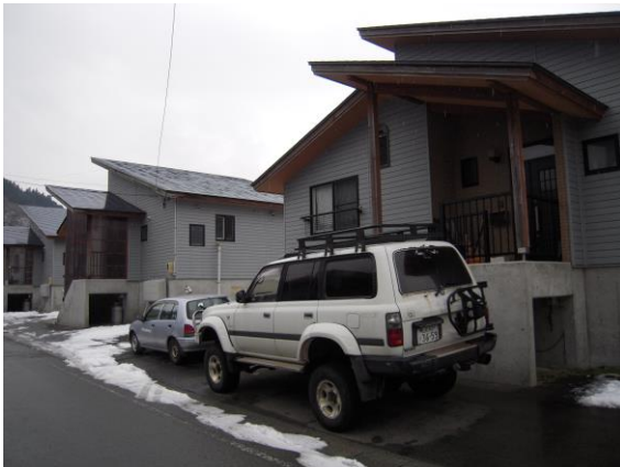
住棟の状況 (A棟～C棟)
