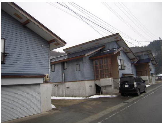
住棟の状況 (F棟～H棟)
