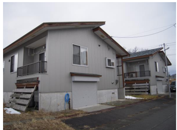
住棟の状況 (I棟、J棟)
