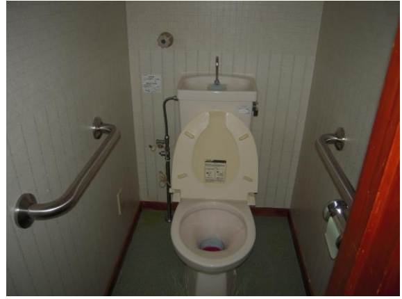
トイレの状況
