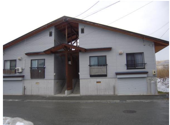
住棟の状況 (D棟)
