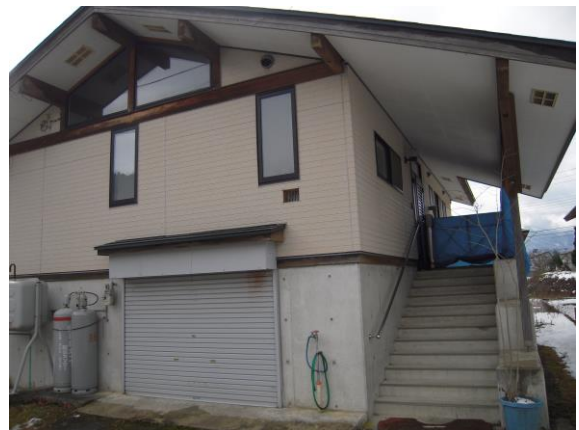
住棟の状況 (Bタイプ)
