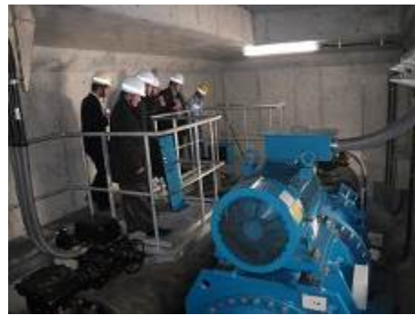
【水車形式】横軸三相誘導発電機 【発電機形式】横軸三相誘導発電機 【発電機出力】135kW ×2台 予想発電量は115万kWh/年 川井浄水場年間電力消費量の約30% 一般家庭年間使用電力量の約335件分
