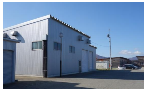
バイオマスボイラ施設の外観②
