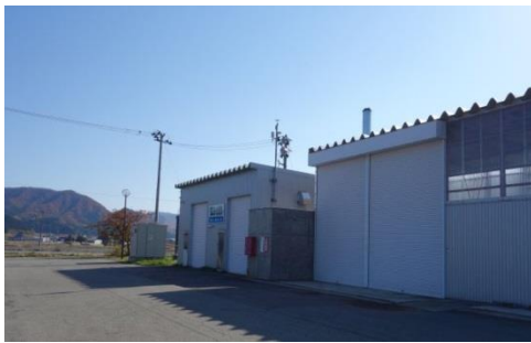
バイオマスボイラ施設の外観①
