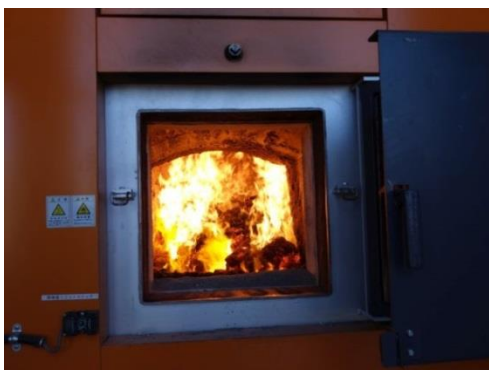
バイオマスボイラの炉内
