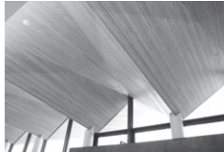
▲新・新庄病院の天井や壁の材料には、県産材木材である最上町のスギや鶴岡市などのカラマツを利用しています。
