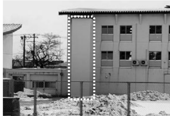
▲大堀小エレベーター工事(点線部分)
