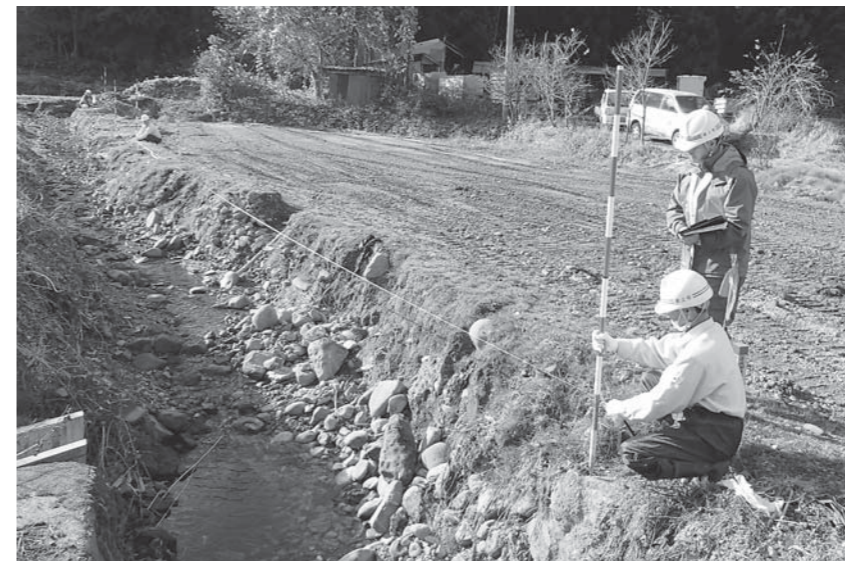
建設課職員 災害現場
