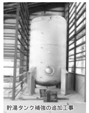
◀ 若者定住環境 モデルタウン 熱供給工事費 16,740 千円
