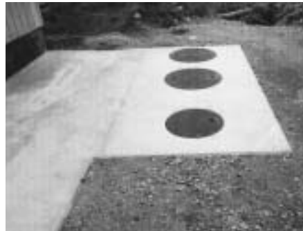
設置増が求められる浄化槽整備
