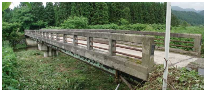
写真 5-1 コンクリート製防護柵
