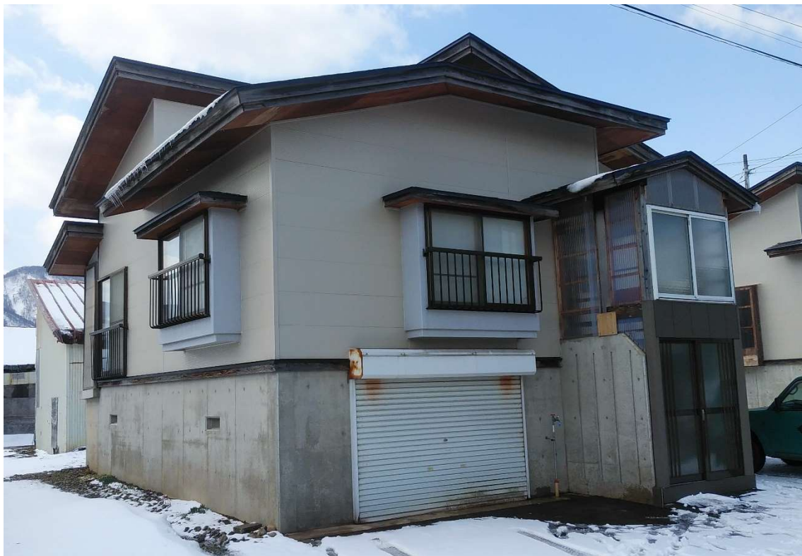
大堀住宅 5号 (最上町大字志茂2572番地) 平成2年(1990年)建築
