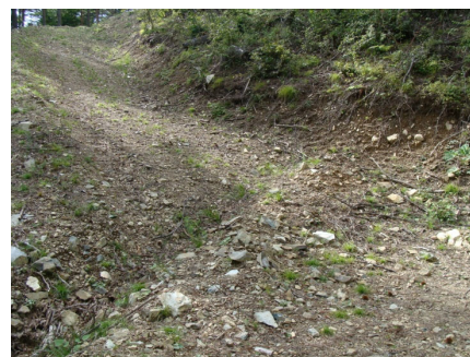
素掘りによる横断溝
