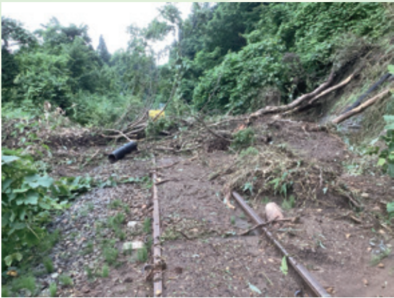
東長沢～長沢間 被災状況 写真提供：JR 東日本東北本部
