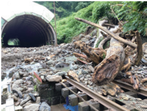
瀬見温泉～東長沢間 被災状況 写真提供：JR 東日本東北本部
