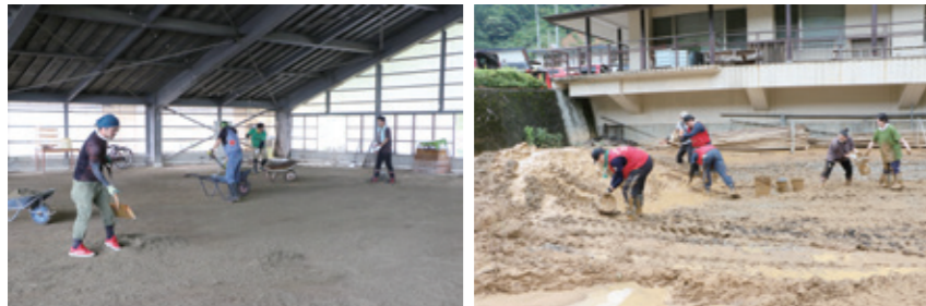
もがみ南部商工会青年部の皆さんがボランティアで、湯の原の屋内ゲートボール場の復旧を行いました。(写真：8月28日) 観松館に流入した泥の掻き出し、搬出作業。町外の方々や高校生からも作業を行っていただきました。(写真：7月31日)
