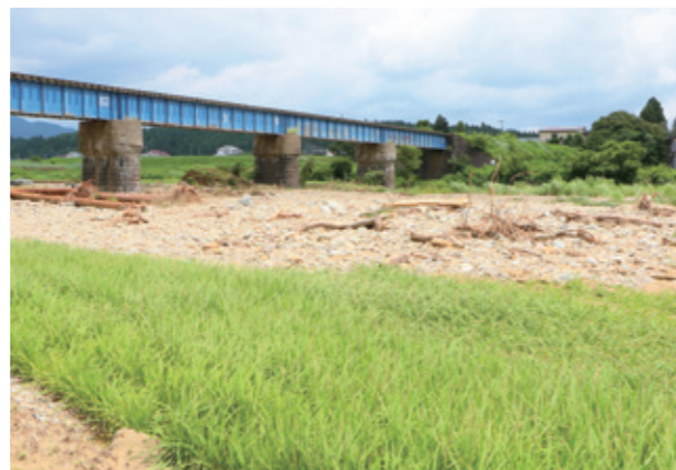
大横川の農地被害。河川から田んぼへ土砂が流入し堆積
