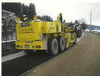
【路上路盤再生工】
