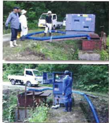
渇水対策：ポンプ設置・管理
