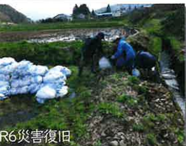
湯水対策 取水堰止め
