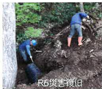
直営施工による水路設置
