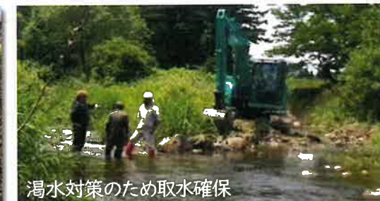
直営施工による水路設置
