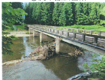
②流木撤去箇所
