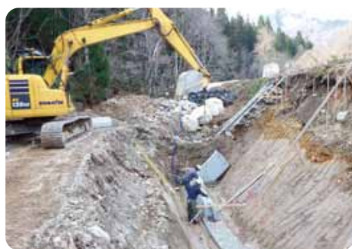
災害復旧工事
