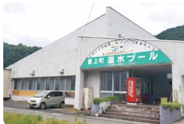
大規模改修予定の温水プール
