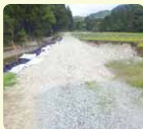
立小路 仏沢川上流 復旧後
