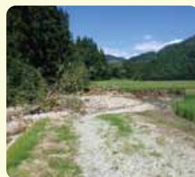
立小路 仏沢川上流 復旧前
