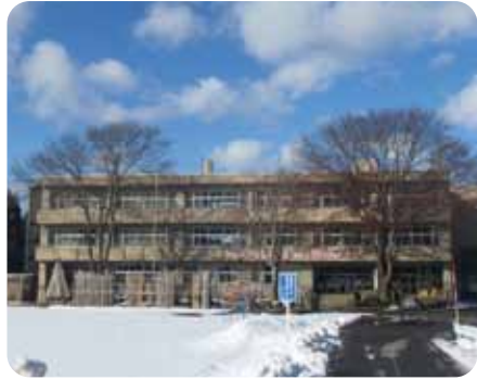
令和8年度に旧富沢小学校解体を予定
