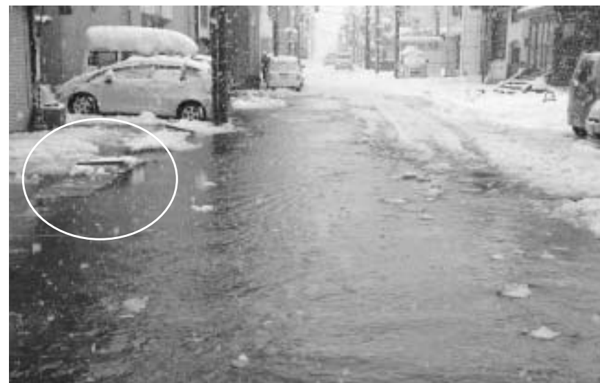
▲ 水が側溝の蓋を押し上げ、流水した向町商店街道路
