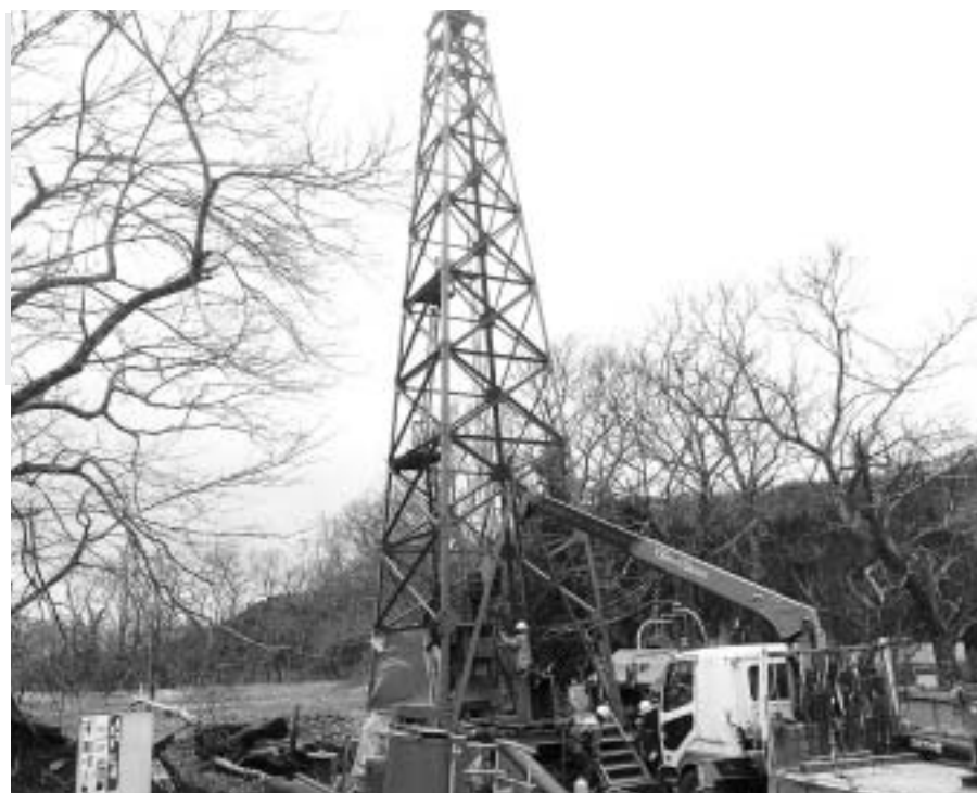
▲ 立小路水源工事
